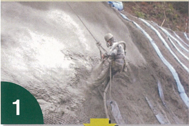
背面吹付（裏面排水材の配置）
