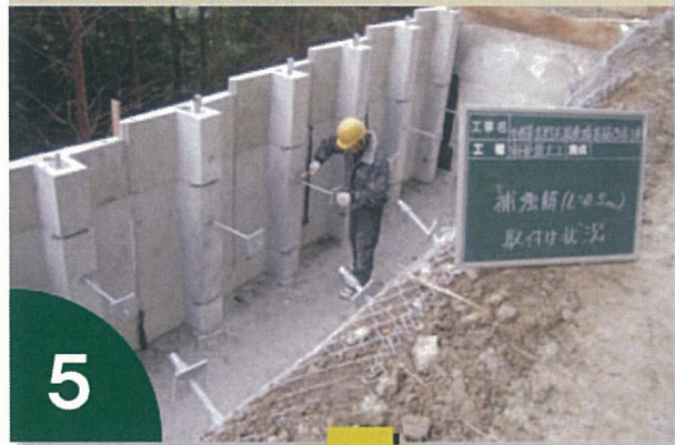
パネルの設置（補強鉄筋プレート）
