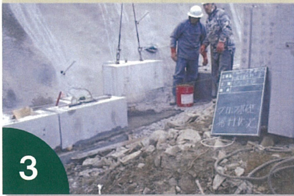
基礎ブロックの設置
