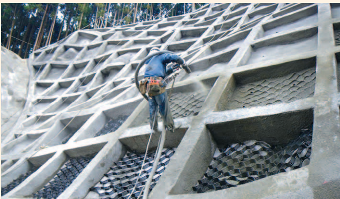
③ 道路法面 補修・復旧工事
