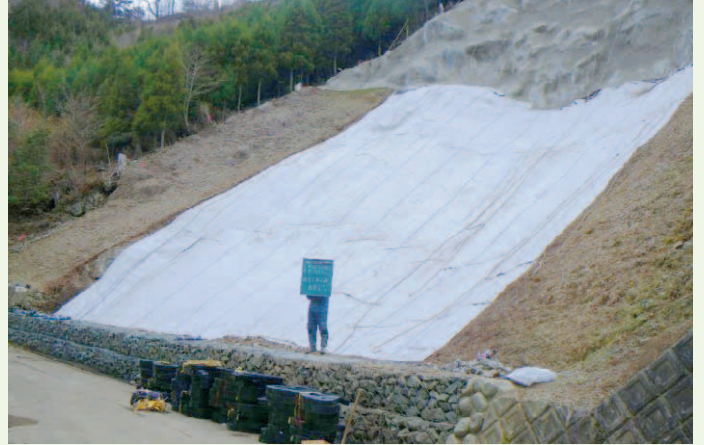
4) ポーラスコンクリート吹付け
