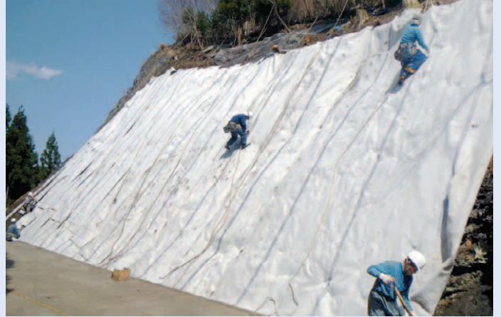
4) ポーラスコンクリート吹付け
