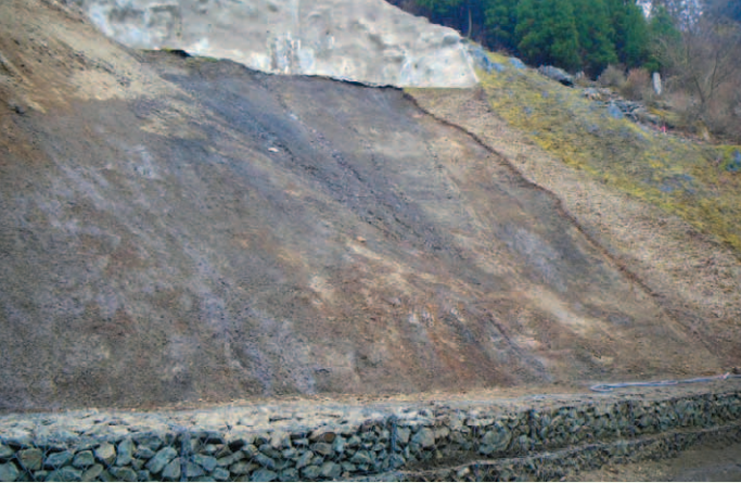
3) ハニカム状フレキシブル型枠 (テラセル) 敷設
