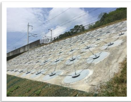
7.台湾新竹県 台湾新幹線線路斜面对策工事
