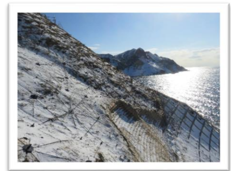
9.北海道礼文島(国立公園内) 元地浜中災害関連緊急工事
