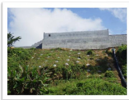
8.沖縄県読谷村 比謝牧原線地すべり防止対策工事
