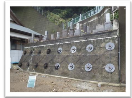
6.神奈川県横須賀市 光龍寺既存石積補強対策工事
