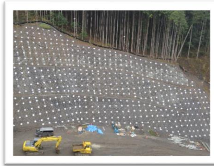
2.奈良県十津川村 大畑瀬溪流保全工事
