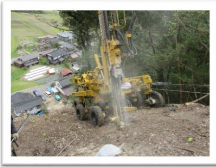
1.鳥取県三朝町 穴鴨2地区急傾斜地崩壊対策工事
