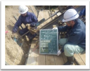
3. ロックボルトの打設工
