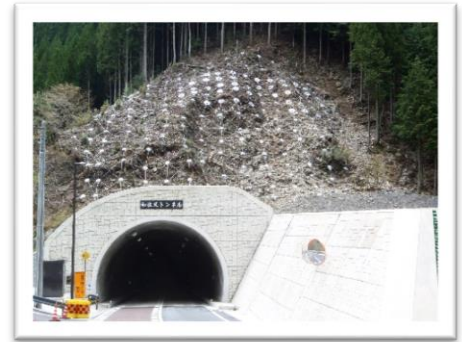
3.奈良県国道 169 号 和佐又トンネル坑口法面对策工事
